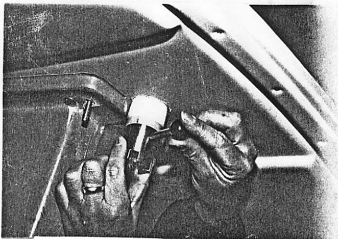
ev. neue Löcher bohren
